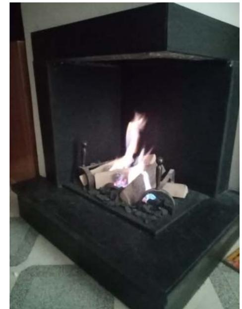
**Esempio di recupero camino aperto esistente con bruciatore a gas metano modello da 45 cm ( 40 x 14 x 10)**
